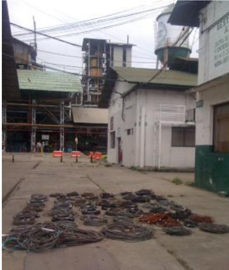
Ahorro de Cables en Instalaciones de CAVSA.
